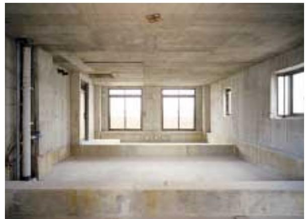
図-1.4 コンクリート打設後の逆スラブ
