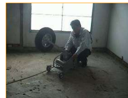
裸スラブ原状実験状況
