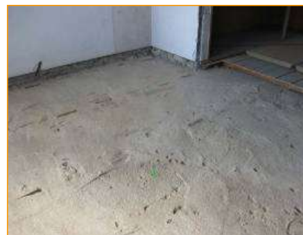
裸スラブ状態
